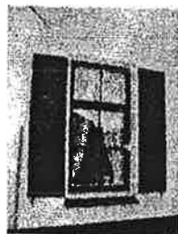
Op de foto links van deze tekst ziet u het resultaat van één ouderwets schuifraam dat geheel is omgebouwd tot een kozijn met boven-slap raam.
